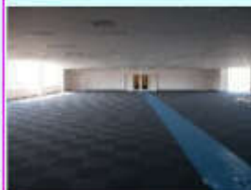
①搬入口から養生していきます。
